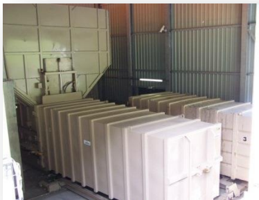
Trémie de compactage et caissons de transfert de Passy
