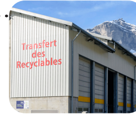
Compactage au quai de transfert des Recyclables - Passy
