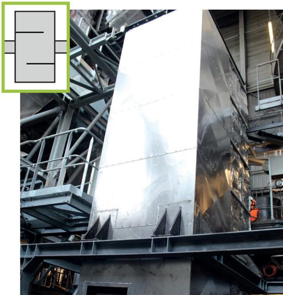
Positionné avant le filtre à manches, le réacteur est un équipement dans lequel sont injectés :
