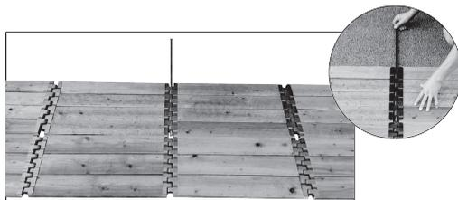
Disposer sur un sol plat les 8 panneaux du kit en constituant 2 rangs (la partie haute et la partie basse du composteur).
