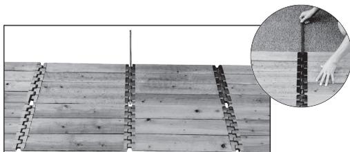
Disposer sur un sol plat les 12 panneaux du kit en constituant 2 rangs (la partie haute et la partie basse du composteur).
