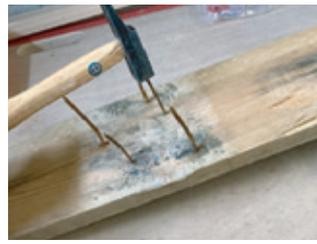
3 - Retirer les clous des planches en utilisant le marteau et le pied de biche.
